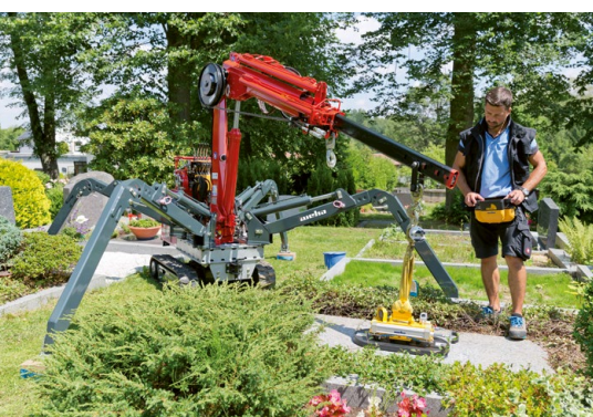
Anheben der Liegeplatte mit dem mobilen Vakuumheber
